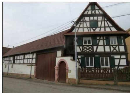
Le porche et l'ancienne porcherie ont été rasés mais la maison d'habitation est restée. DR
