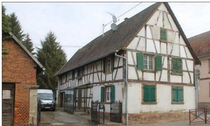
La maison Greder, vouée à la démolition, date du XVII e s. Document remis
