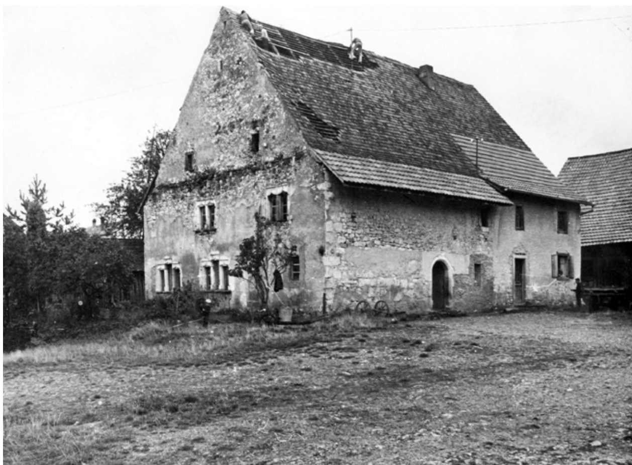
Figure 1. Hiver 1972/1973. L'intervention de l'association « Maisons paysannes d'Alsace » aurait dû se limiter à des réparations urgentes de la toiture. Mais au cours de ce premier chantier, s'est imposée la nécessité d'une restauration radicale de l'édifice, le pignon étant à la veille de s'écrouler.
