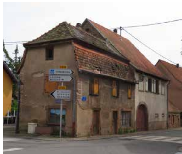
Démolition interdite à Ottrott par décision de justice.
