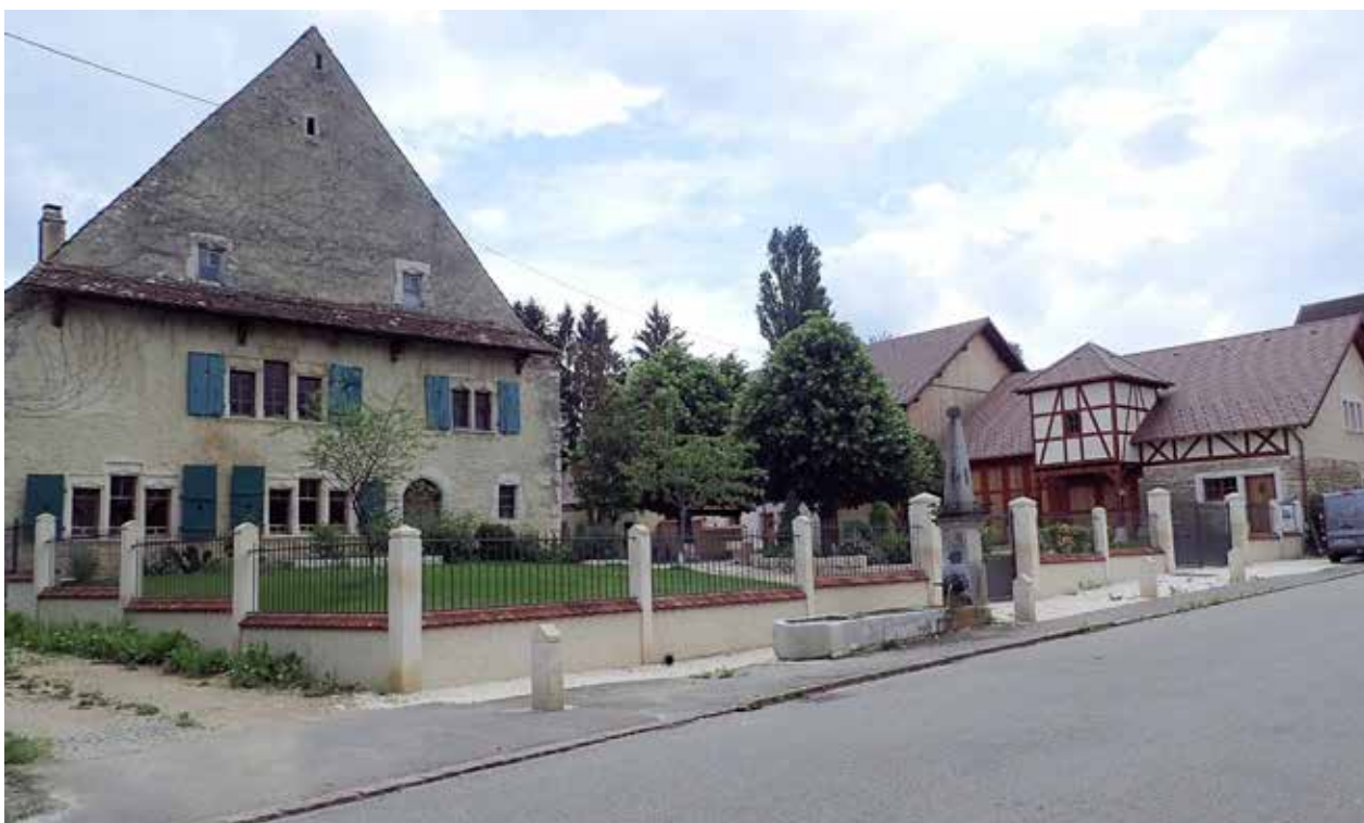
Figure 4. 2018. Les temps ont bien changé. La nouvelle tour-pigeonnier veille sur un ensemble dorénavant clos. La restauration du « Tribunal » a traversé 45 ans. La « rénovation » autorisée va mettre ce monument classé au diapason de son nouvel environnement.
