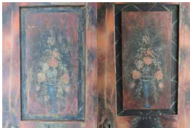
Panneau de porte après décapage, puis après restauration.
