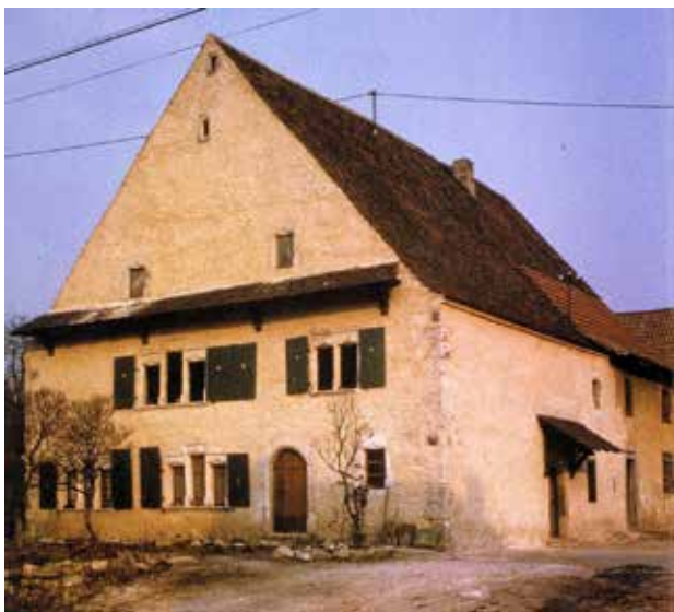
Figure 3. 1976. La restauration de l'ensemble de l'édifice est achevée (à l'exception de la partie arrière que l'on distingue à gauche au fond). Notez le rétablissement des rives de toiture sur pignon et façade dans leur forme d'origine.
