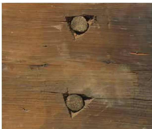
Face non apparente du plancher avec les avant-trous de forme triangulaire.
