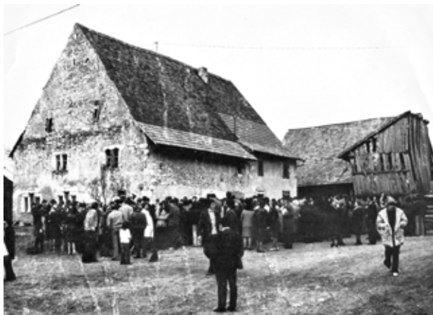
Figure 2. 1973. Avant le lancement des grands chantiers, les visites guidées du village et du bâtiment remportent un succès considérable. Notez la partie arrière bien visible.
