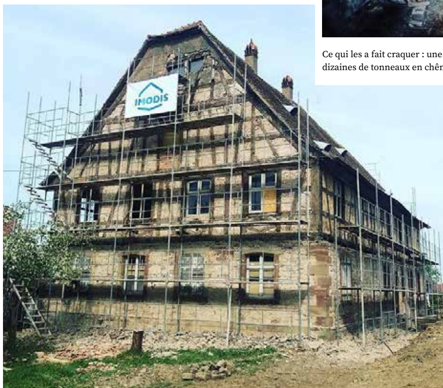
Les travaux avancent .... © SAS Imodis
