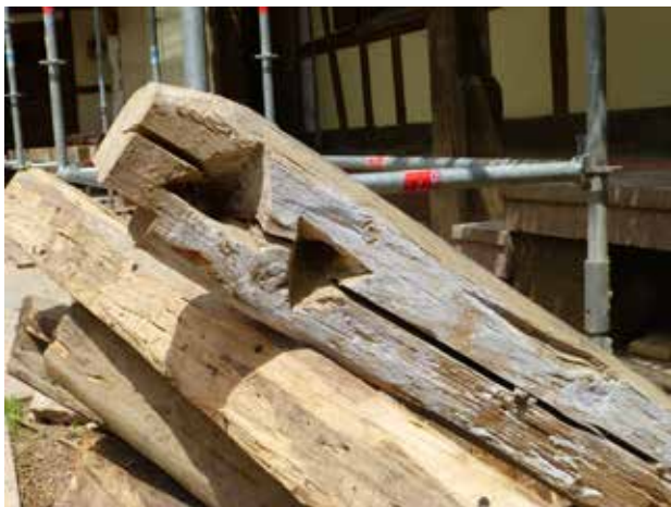
Avant-trous et forages pour la fixation des liens. Chantier de restauration de la ferme 's Jungrote à Schnersheim, 2012.
