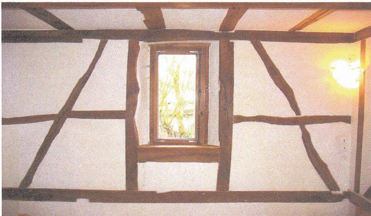
Figure 4 : Mur enduit de chaux
