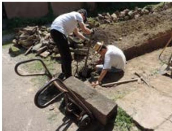
*Bénévoles à l'œuvre pour la construction d'un mur de soutènement en moellons de grès.*
