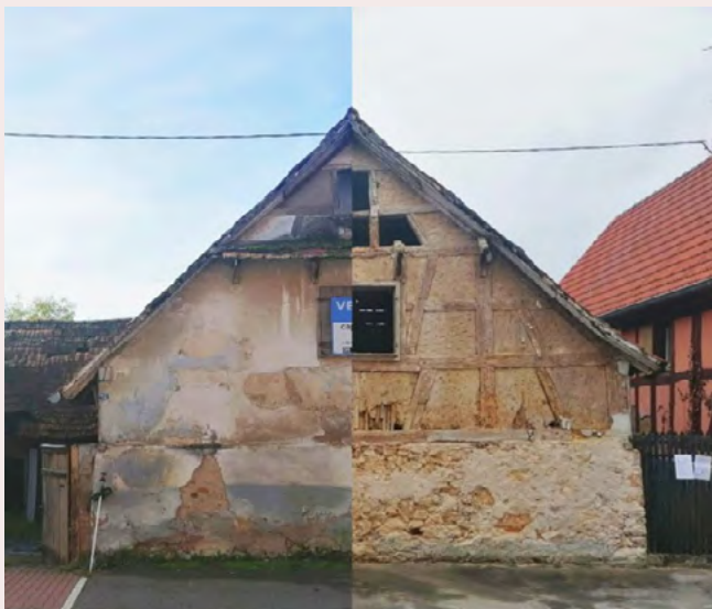
Le pignon de la maison, débarrassé de son enduit, révèle de nouvelles potentialités
