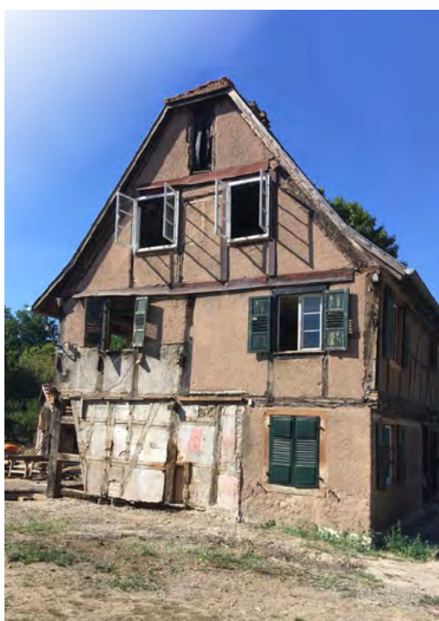
Façade Sud avant et après travaux
