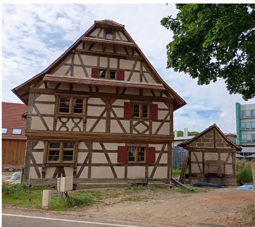
Façade Nord avant et après travaux
