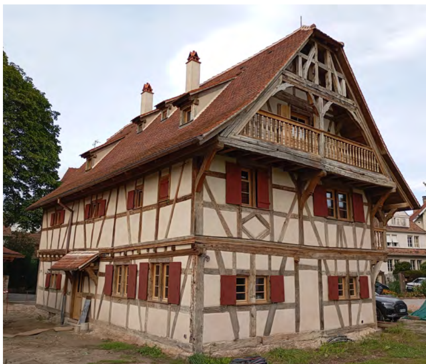
Façade Ouest avant et après travaux
