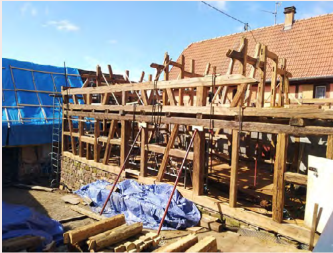
Maintien de la structure initiale, démontage et remontage à l'identique » c'est la 2 ème option qui est retenue
