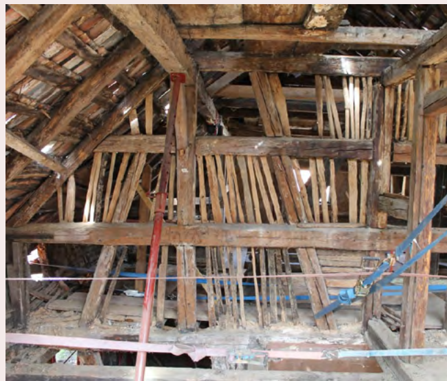
Le démontage était alors imminent, et la maison était tellement penchée et tellement fragile que nous avons dû la sangler de toutes parts pour qu'elle ne s'effondre pas !
